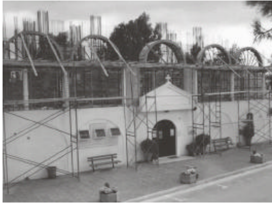
Εικ 1. Ανέγερση της επάνω στάθμης του ναού, πέραν του ύψους των 2,40 μ. (25 Νοεμβρίου 1999).
